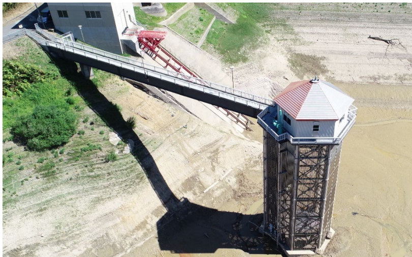
新十津川ダム取水塔
